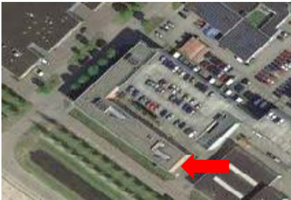
Overzicht complex c.q. hoofdentree
